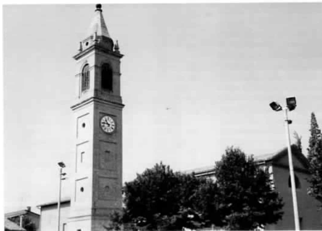
Lo sveltante campanile della parrocchiale di Bubano. Su disegno di Francesco Brighenti di Bologna, come quello di Borgo Tossignano. La chiesa di cui si vede la parte più alta fu quasi interamente rifatta negli anni 1974-75 dall' Arc. don Gaetano Bianconcini.
