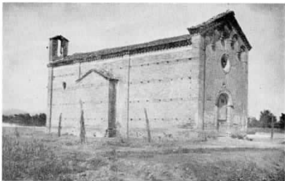
Veduta della chiesa nel corso dei restauri del 1924 - 26
