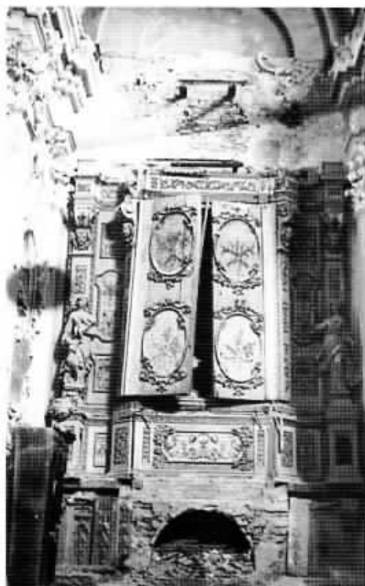
Foto del Reliquiario dopo la distruzione bellica, prima dell'inizio dei restauri.
